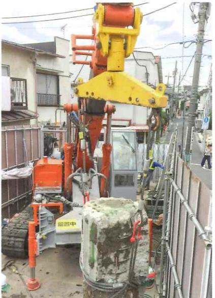
杭打機に専用特殊吊り治具を装着して「場所打ち杭」を引き抜く。
