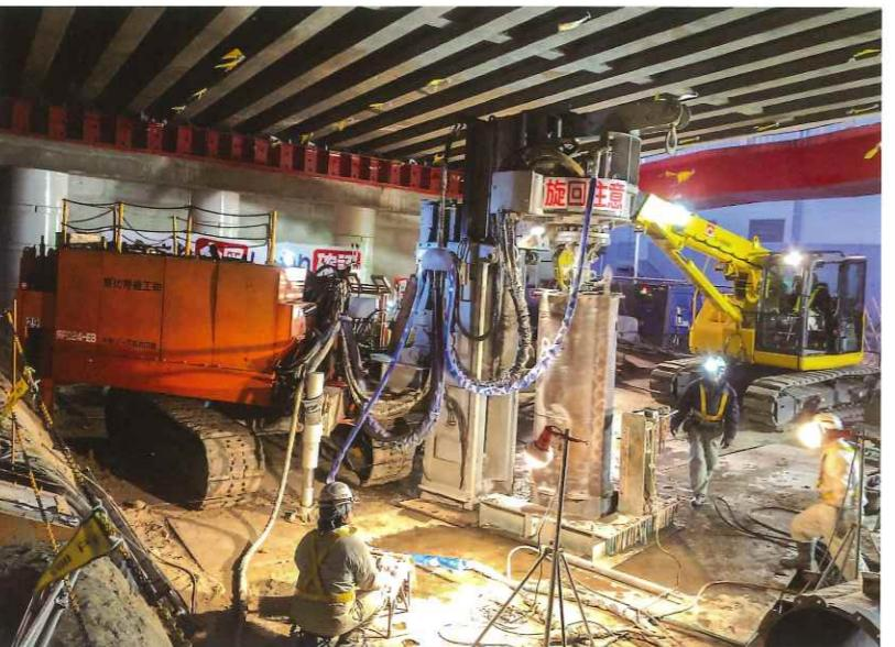
幹線道路の桁下、低空頭下でかつ狭隘地でのRC杭引抜施工。
